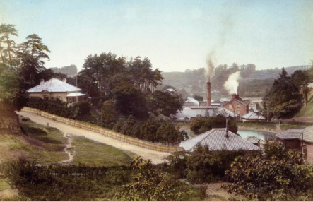
北方・天沼のビール工場(明治中期) / 横浜開港資料館所蔵
